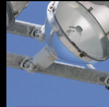
LUMINARIOS Y SU MONTAJE
